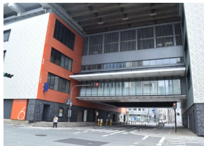
図2 船場センタービルの棟間通路
